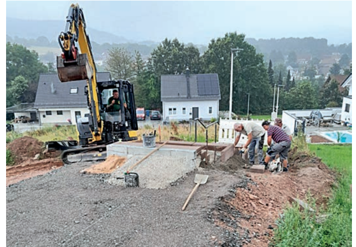
Abb.: Lückenschluss Treppenanlage
