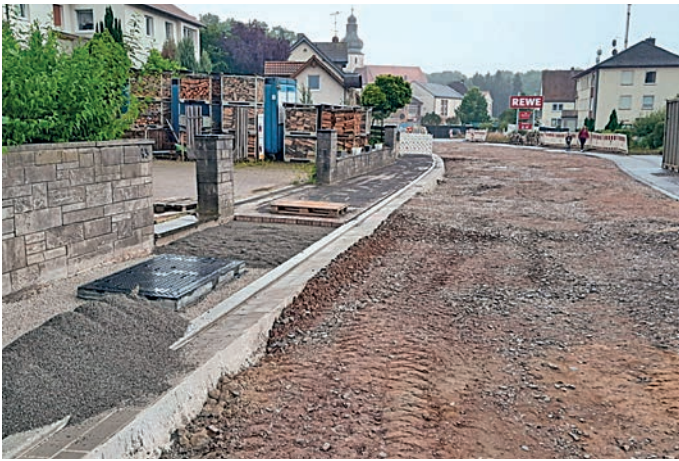
Abb.: Herstellung Gehweg
