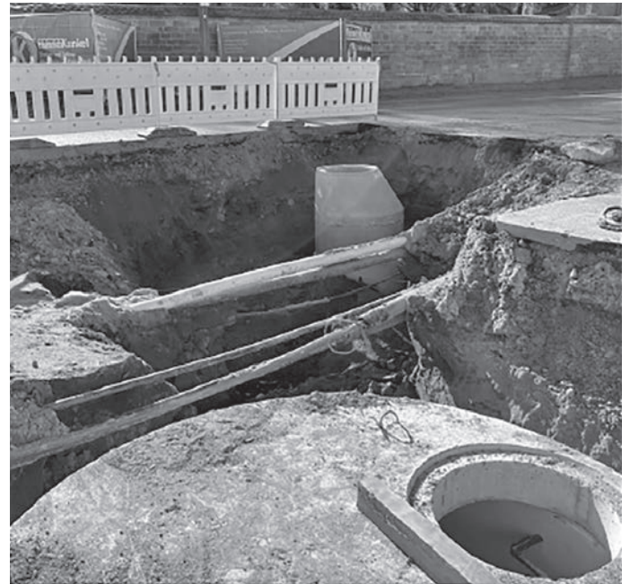
Abb.: Abschnittsübergreifende Kanalbauarbeiten BA0 / BA1
