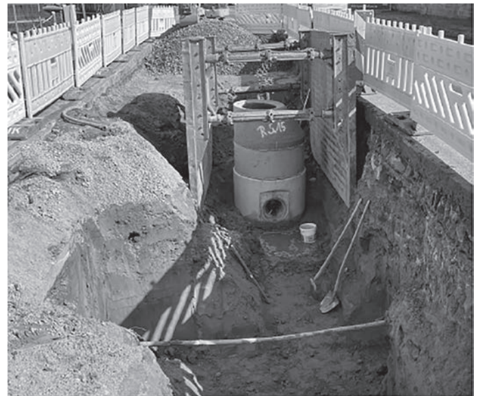
Abb.: Neues Schachtbauwerk Aschaffenburger Str.
