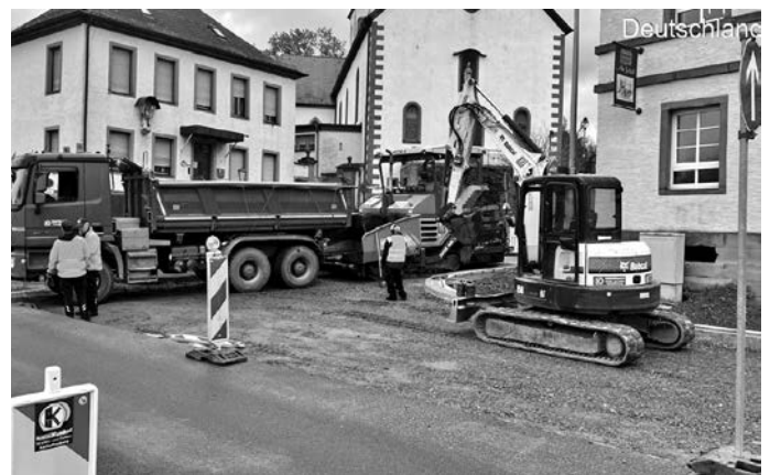
Abb.: Asphaltarbeiten Einmündung Ernstkirchen
