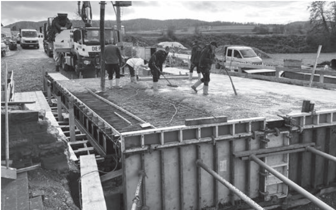
Abb.: Betonarbeiten am Brückenüberbau
