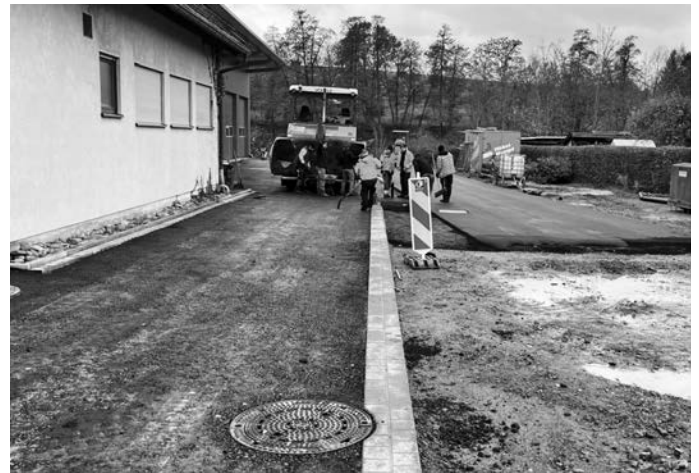
Abb.: Fertigstellung der Asphaltdeckschicht im Bereich der Freiwilligen Feuerwehr
